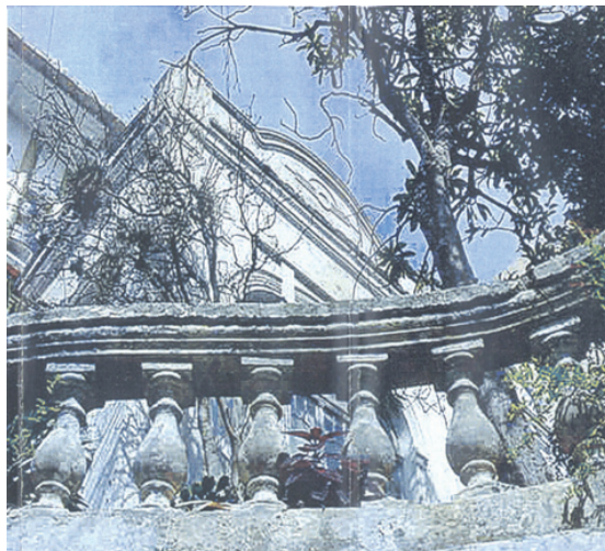
Figura 15 - Balaústre de acesso à casa
